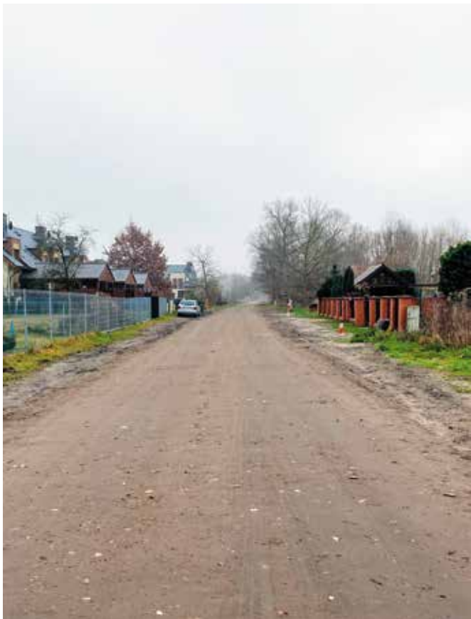
Przebudowa sieci wodociągowej na ul. Wakacyjnej w Zieleniewie
