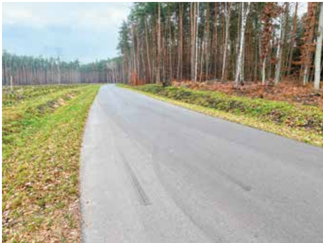
Budowa drogi Cisewo - Zieleniewo
