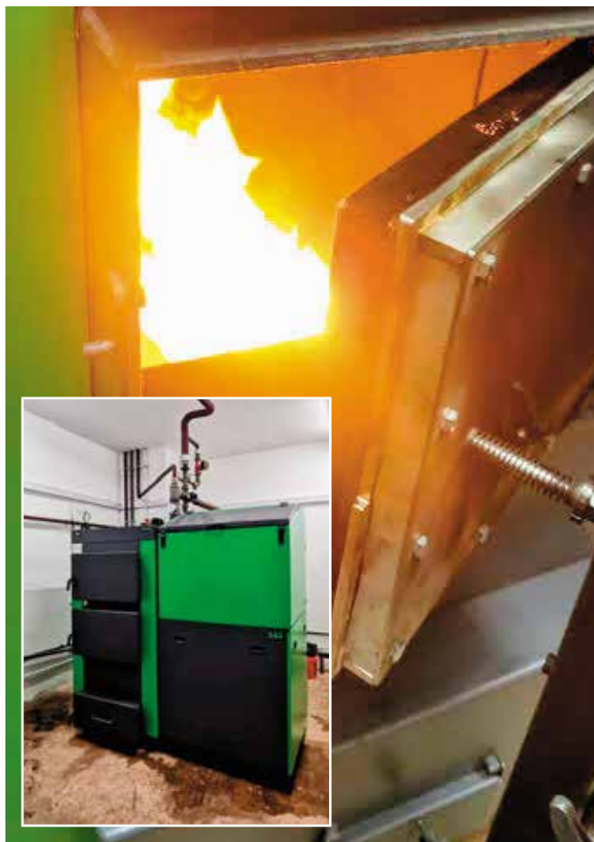
Przebudowa kotłowni w SP w Kunowie
