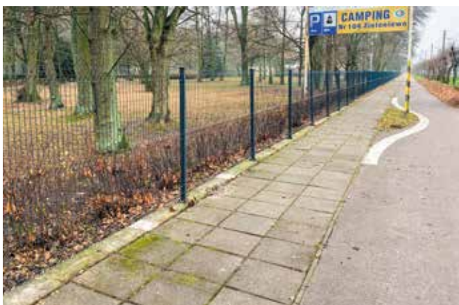
Zakup i montaż ogrodzenia Campingu
