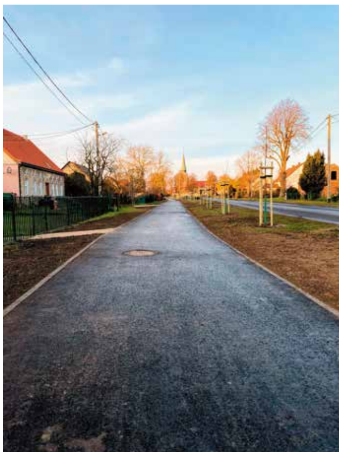
Kontynuacja ścieżki pieszo-rowerowej przy drodze wojewódzkiej w Bielkowie
