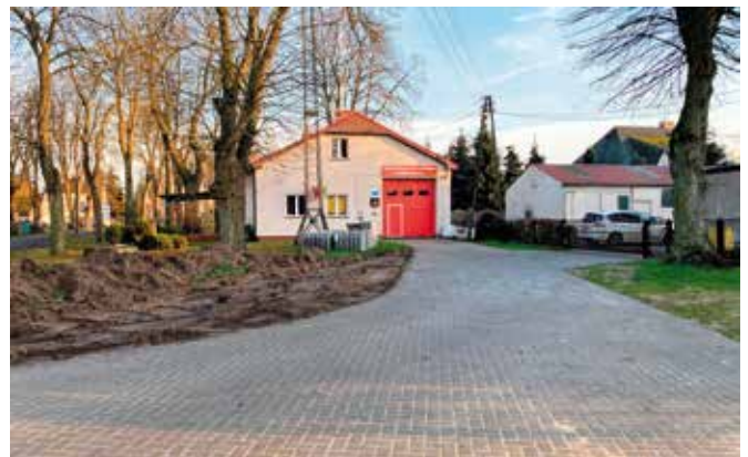
Wykonanie podjazdu do remizy OSP w Niedźwiedziu
