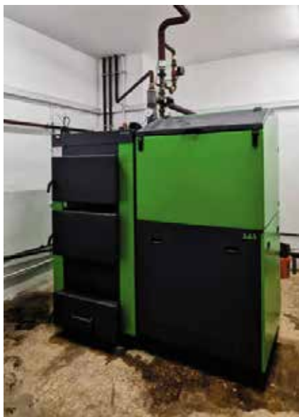
Przebudowa kotłowni w SP w Kunowie
