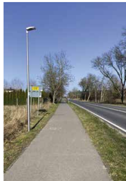
Przebudowa drogi Kobylanka-Bielkowo
