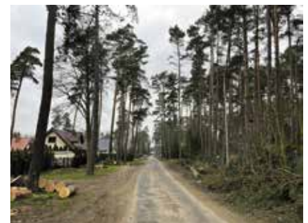
Przebudowa dróg na tzw. rekreacji w Morzyczynie
