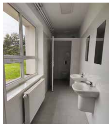
Remont świetlicy w Bielkowie
