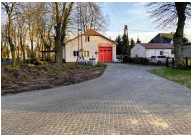
Wykonanie podjazdu do remizy OSP w Niedźwiedziu
