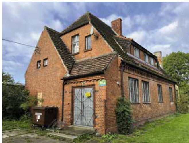
Przebudowa świetlicy wiejskiej w Kunowie
