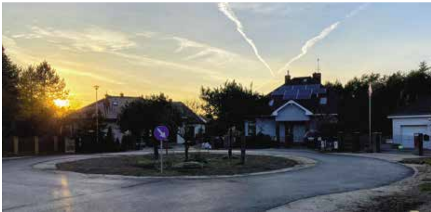
Przebudowa dróg gruntowych na os. Północnym w Morzyczynie
