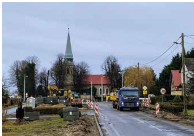
Przebudowa drogi w Bielkowie
