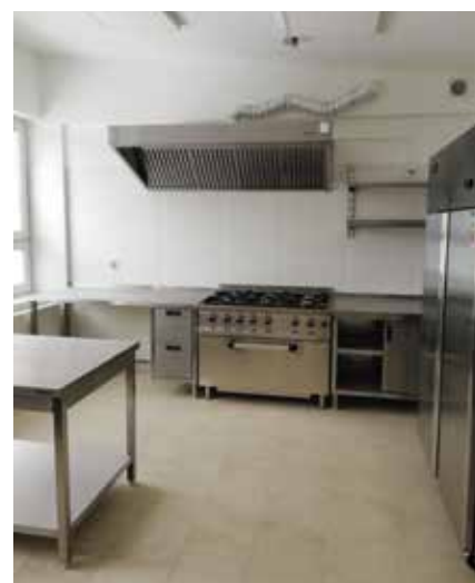
Remont świetlicy w Bielkowie
