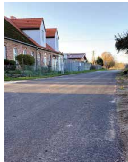
Ulepszenie odcinka drogi gruntowej w Wielichówku
