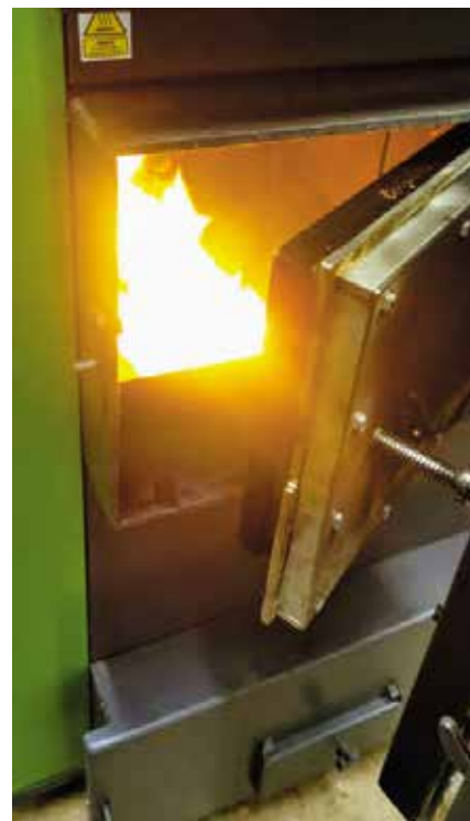
Przebudowa kotłowni w SP w Kunowie
