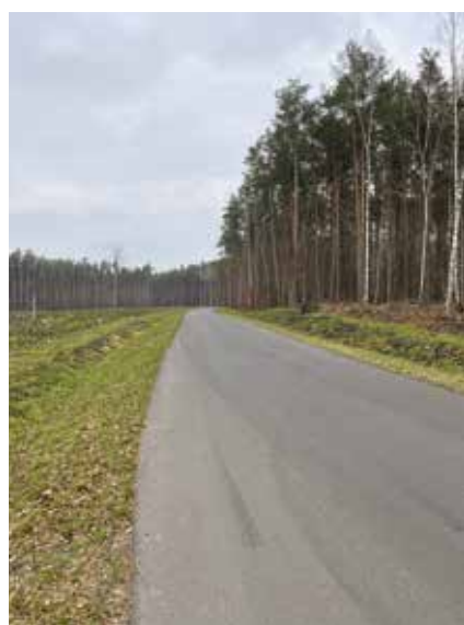
Budowa drogi Cisewo - Miedwiecko
