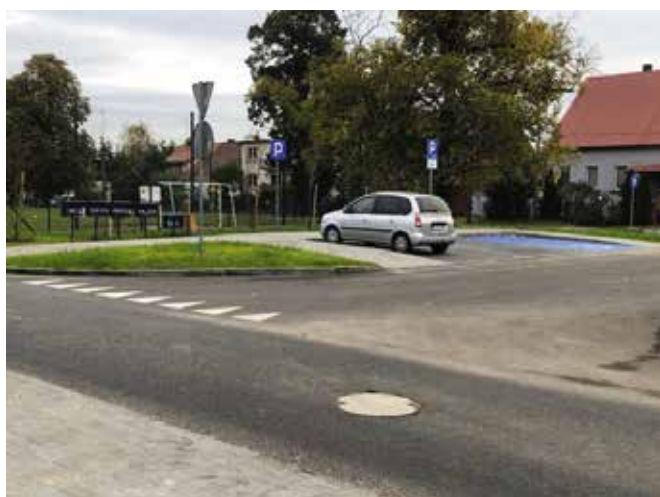
Przebudowa drogi powiatowej w Kunowie
