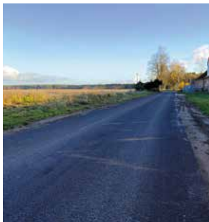
Ulepszenie odcinka drogi gruntowej w Wielichówku
