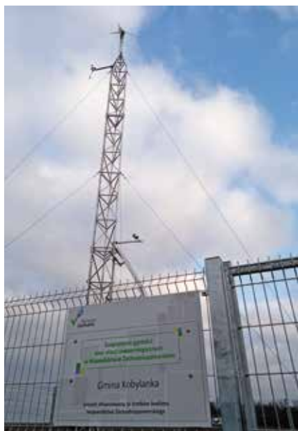
Stacja meteorologiczna w Bielkowie
