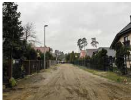
Przebudowa dróg na tzw. rekreacji w Morzyczynie
