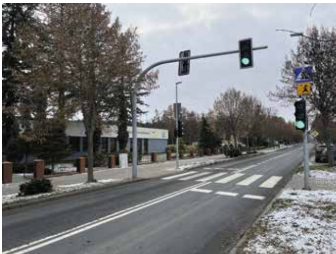
Sygnalizacja świetlna na ul. Szkolnej w Kobylance
