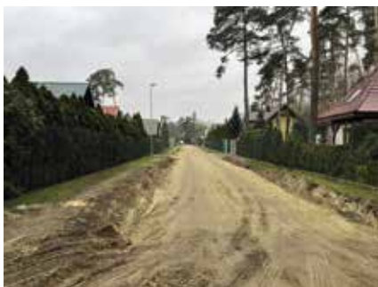
Przebudowa dróg na tzw. rekreacji w Morzyczynie
