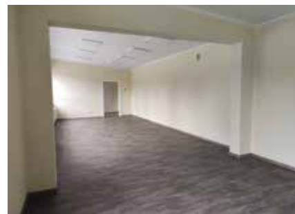
Remont świetlicy w Bielkowie
