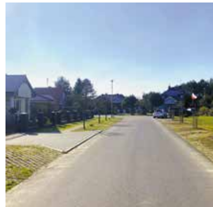
Przebudowa dróg gruntowych na os. Północnym w Morzyczynie
