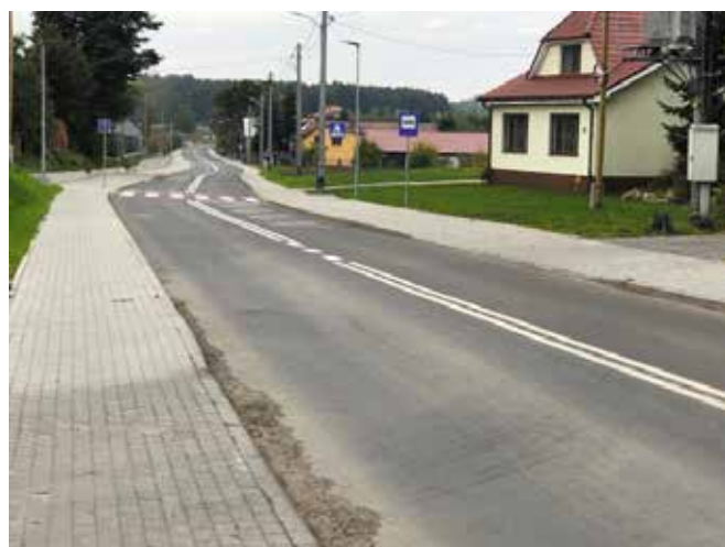
Przebudowa drogi powiatowej w Kunowie
