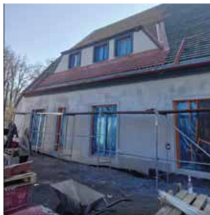
Remont świetlicy wiejskiej w Kunowie
