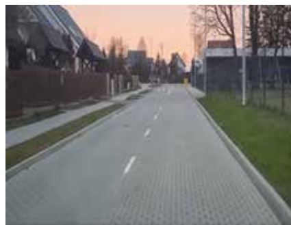
Droga przy szkole podstawowej w Kobylance
