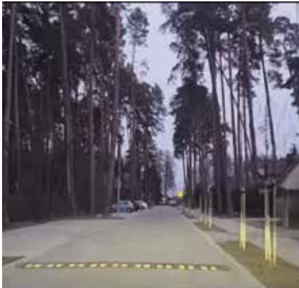
Budowa dróg na tzw. rekreacji
