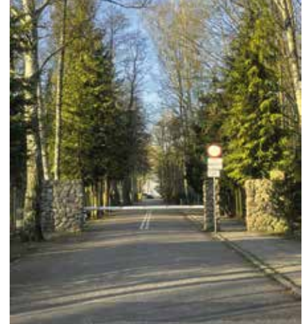
Montaż szlabanu przy wjeździe na plażę w Zieloniewie
