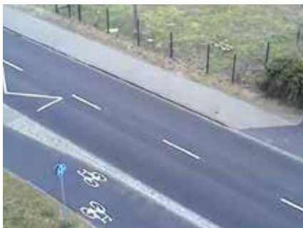
Budowa drogi w Jęczydole
