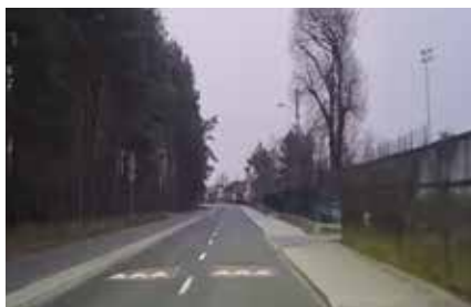
Budowa drogi w Jęczydole
