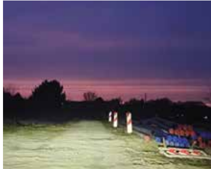
Przebudowa sieci wodociągowej ul. Magellana w Kobylance
